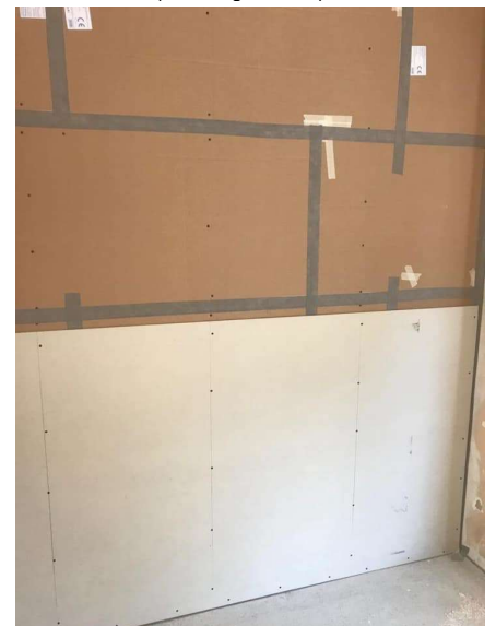
Fissaggio lastra di rivestimento in cartongesso standard, ancorata direttamente al pannello PHONESTAR (1 vite ogni 25cm)
