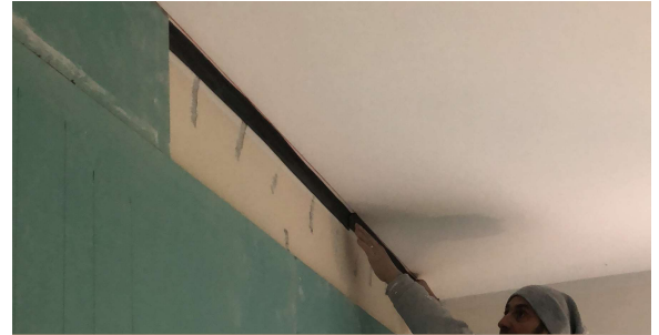
Posa delle guarnizioni Silenz TAGLIAMURO GIPS
