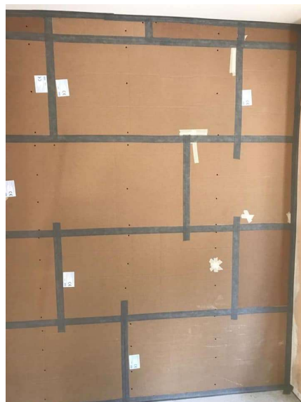
Nastratura dei giunti con nastro SONORA TAPE
