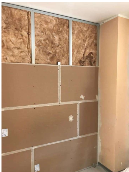
Posa dell'intelaiatura zincata con coibente 3therm FLEX e fissaggio PHONESTAR con 12 viti/pannello
