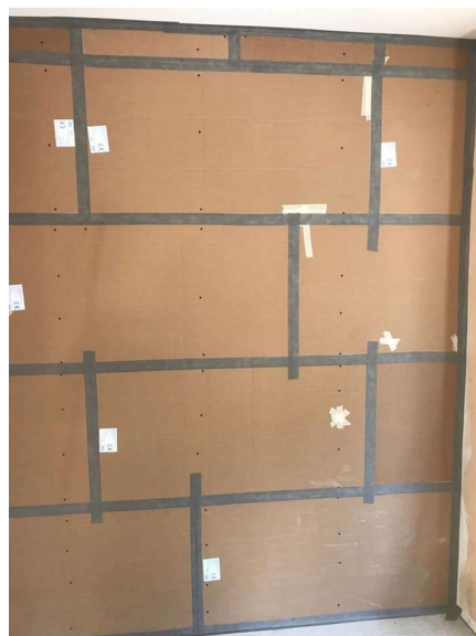
Nastratura dei giunti con nastro SONORA TAPE
