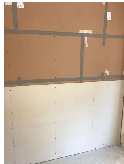
Fissaggio lastra di rivestimento in cartongesso standard
