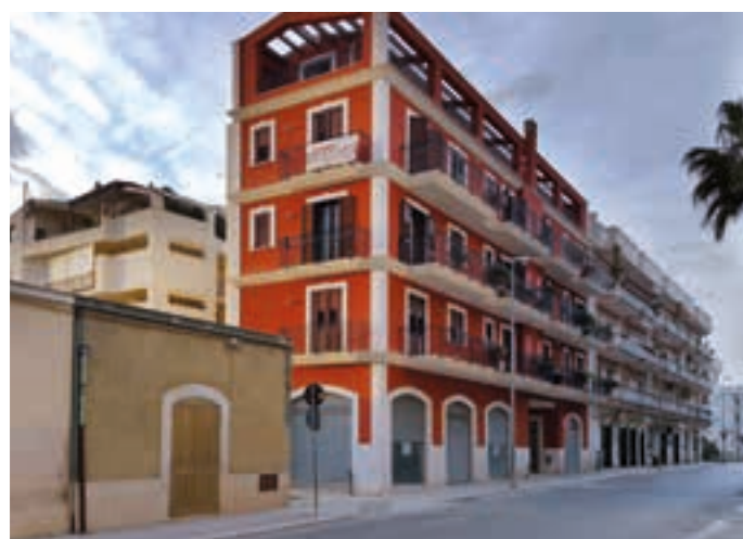
Corato (BT) Murature esterne GASEBETON® con finitura ad intonaco
