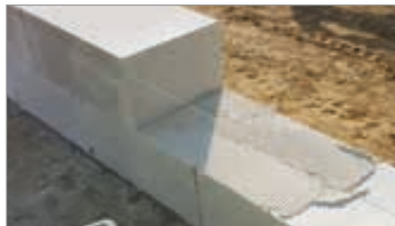
Posa di blocchi GASEBETON® ENERGY con INCOLLARASA su prima fila di BLOCCO IDRO
