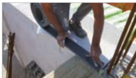
Posa di BANDELLA AMMORTIZZANTE per la creazione del giunto in sommità alla muratura non portante
