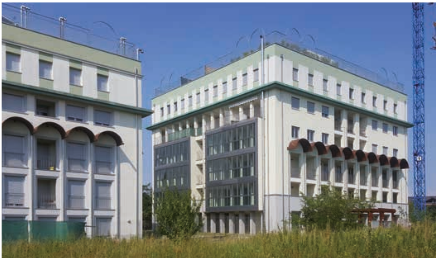
Legnano (MI) Murature interne ed esterne GASBETON® con ciclo completo di intonaco e rasatura
