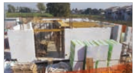
Vista globale del cantiere durante l'esecuzione delle murature del piano terra
