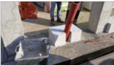
Posa del BLOCCO IDRO sagomato in opera per alloggiare tubo corrugato
