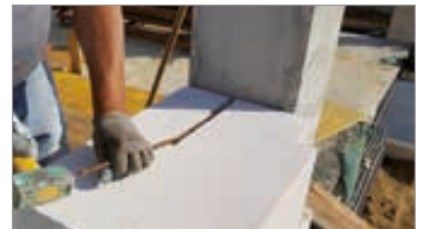
Esecuzione dell'ancoraggio della muratura al pilastro con barra d'acciaio
