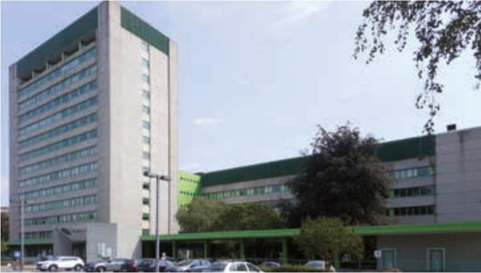
Sesto San Giovanni (MI), clinica privata Murature interne GASBETON® con finitura ad intonaco e murature esterne isolanti GASBETON® rivestite da facciata ventilata in marmoresina.
