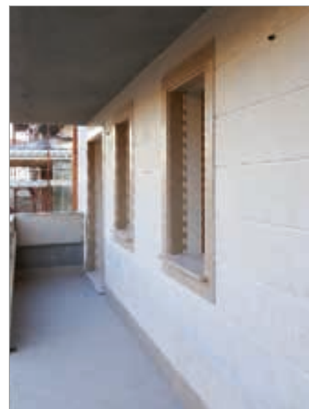
Dettaglio rivestimento lapideo di facciata e contorni delle aperture
