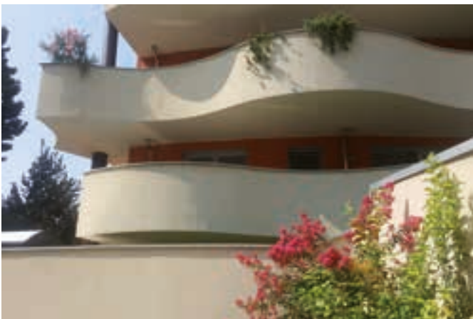
Legnano (MI) Murature interne ed esterne GASBETON® con ciclo completo di intonaco e rasatura
