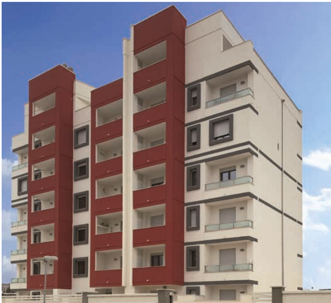
Lecce Murature esterne GASEBETON® con finitura ad intonaco
