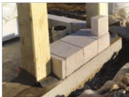
Posa blocchi GSBETON® ENERGY sp. 50 cm
