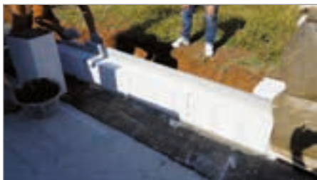
Posa BLOCCO IDRO con malta bastarda stesa su guaina bituminosa
