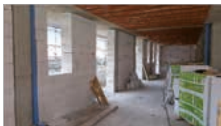
Tamponamento esterno realizzato con blocchi GASBETON® ENERGY sp. 40 cm
