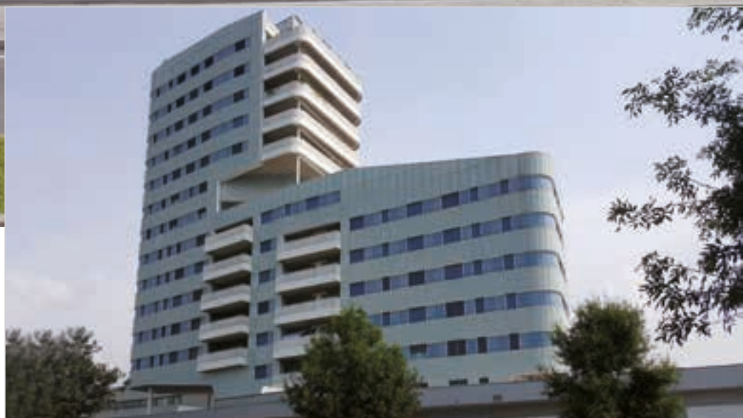
Brescia, Complesso Futura terziario e residenziale Murature interne ed esterne GASBETON® con facciata ventilata.
