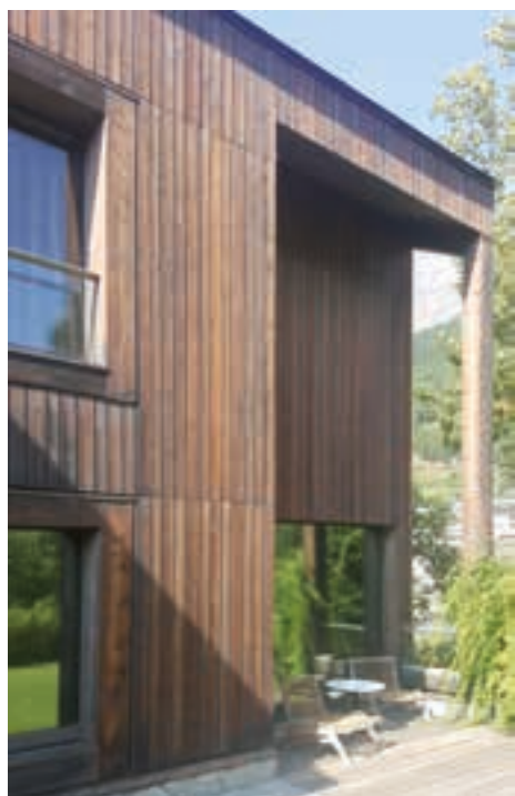
Bormio (SO), Hotel Eden Murature esterne GASBETON® con finitura in doghe di legno.
