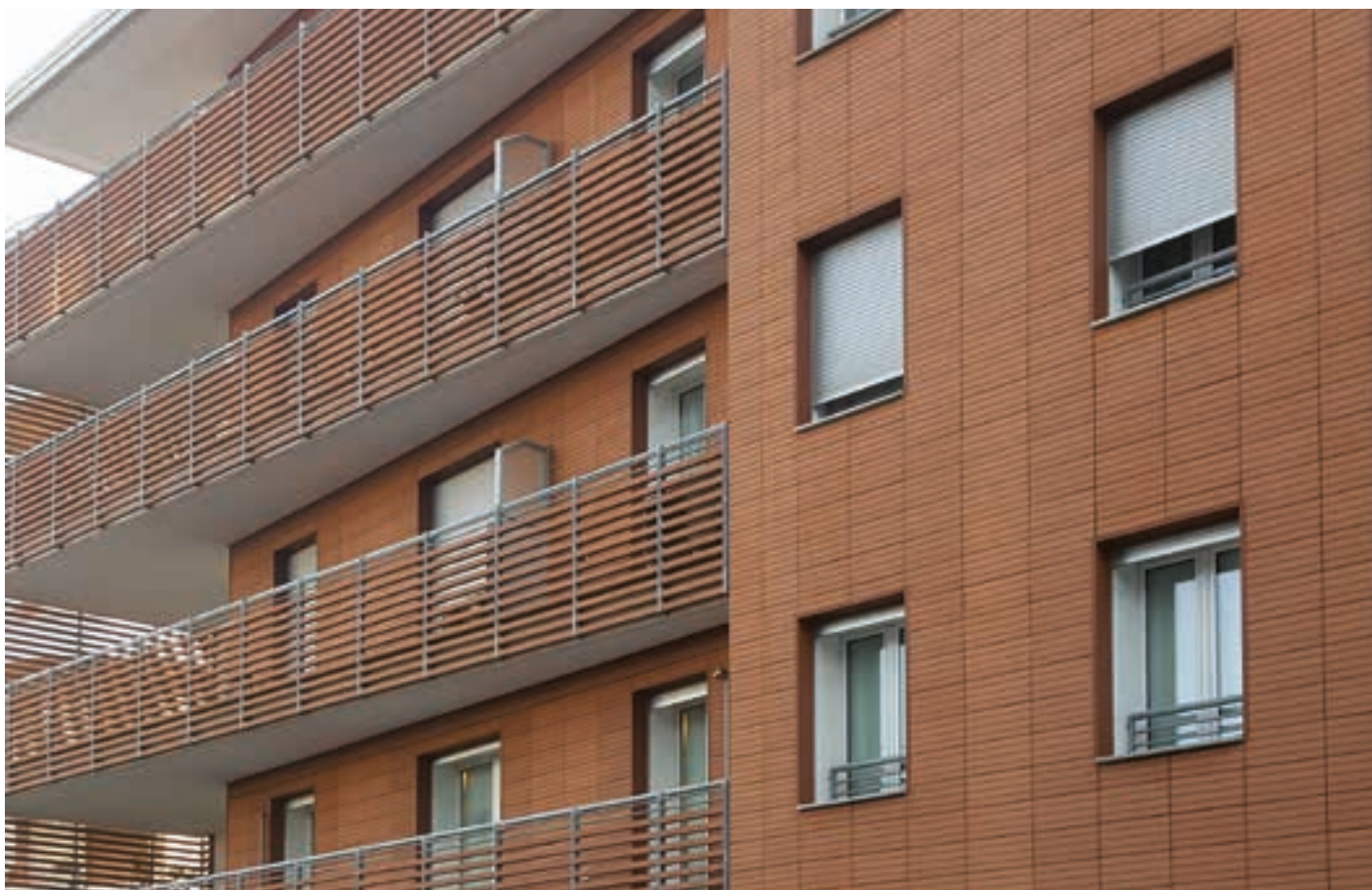
Cinisello Balsamo (MI) - Progetto di Studio Guzzo Murature interne ed esterne GASBETON® con finitura ad intonaco ed in parte facciata ventilata.
