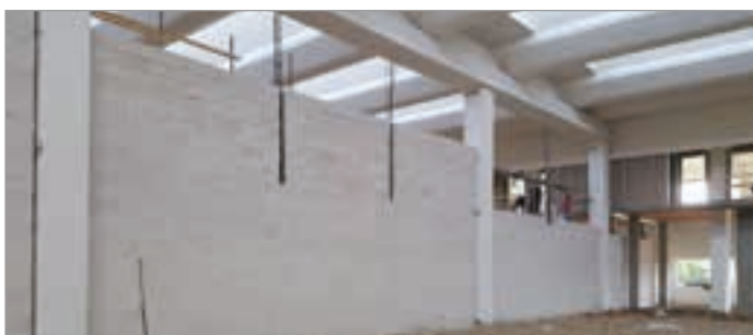
Realizzazione irrigidimenti verticali in c.a. protetti da tavella GASBETON® EVOLUTION sp. 5 cm
