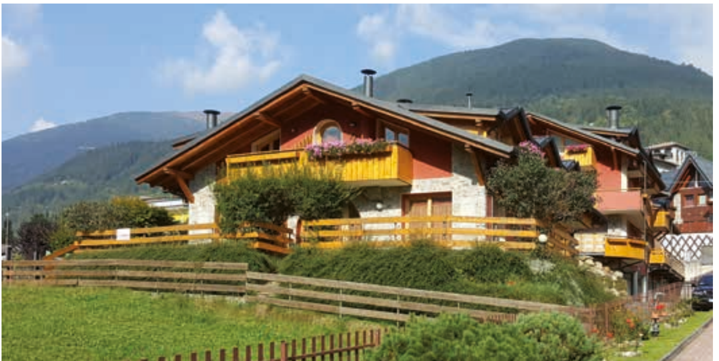
Veza d'Oglio (BS) Murature esterne GSBETON® con finitura ad intonaco e porzioni con rivestimenti in pietra e legno
