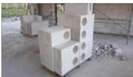
BLOCCHI FORATI e CANALETTA per la realizzazione di irrigidimenti in c.a.
