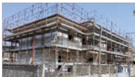
Completamento del tamponamento
