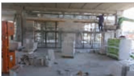
Posa dei blocchi e realizzazione in opera di architravi con BLOCCO CANALETTA
