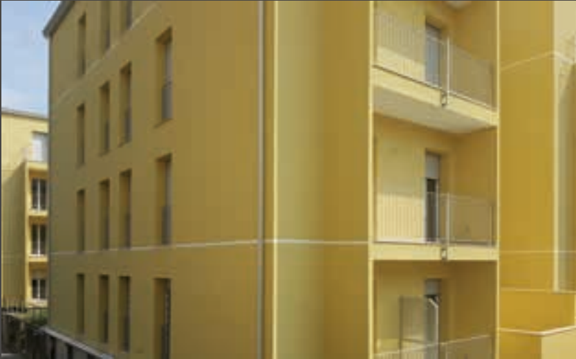
Vimodrone (MI) Ristrutturazione e sopralzo di edifici esistenti. Murature interne GASBETON® con finitura ad intonaco
