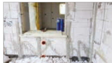
Prime fasi di applicazione dell'intonaco esterno MULTICEM
