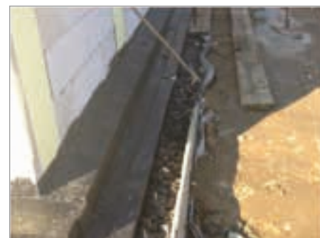
Isolamento laterale platea di fondazione
