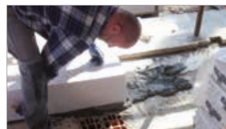
Realizzazione primo corso con BLOCCO IDRO posato su MALTA ANCORANTE IDRO
