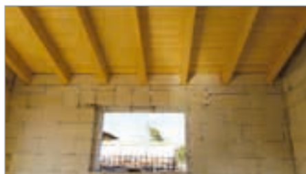
Formazione voltini per apertura con architravi realizzati in opera
