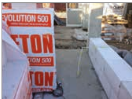
Posa blocchi GSBETON® EVOLUTION sp. 30 cm
