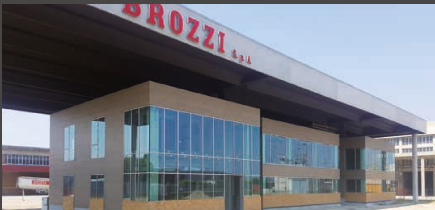
Viadana (MN), edificio per uffici Studio Arch. Bo, murature esterne GSBETON® con facciata ventilata.
