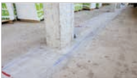
Cordolo di partenza eseguito con MALTA ANCORANTE IDRO
