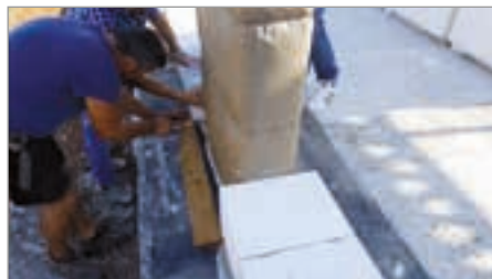
Isolamento ponte termico con lana minerale e tavella GSBETON® EVOLUTION sp. 5 cm
