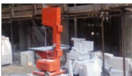
Taglio a misura dei blocchi ACTIVE con sega a nastro per GASEBETON®
