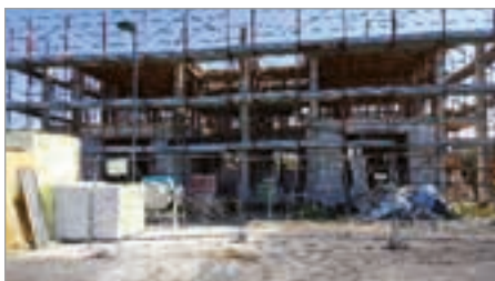
Esecuzione tamponamento piano terra
